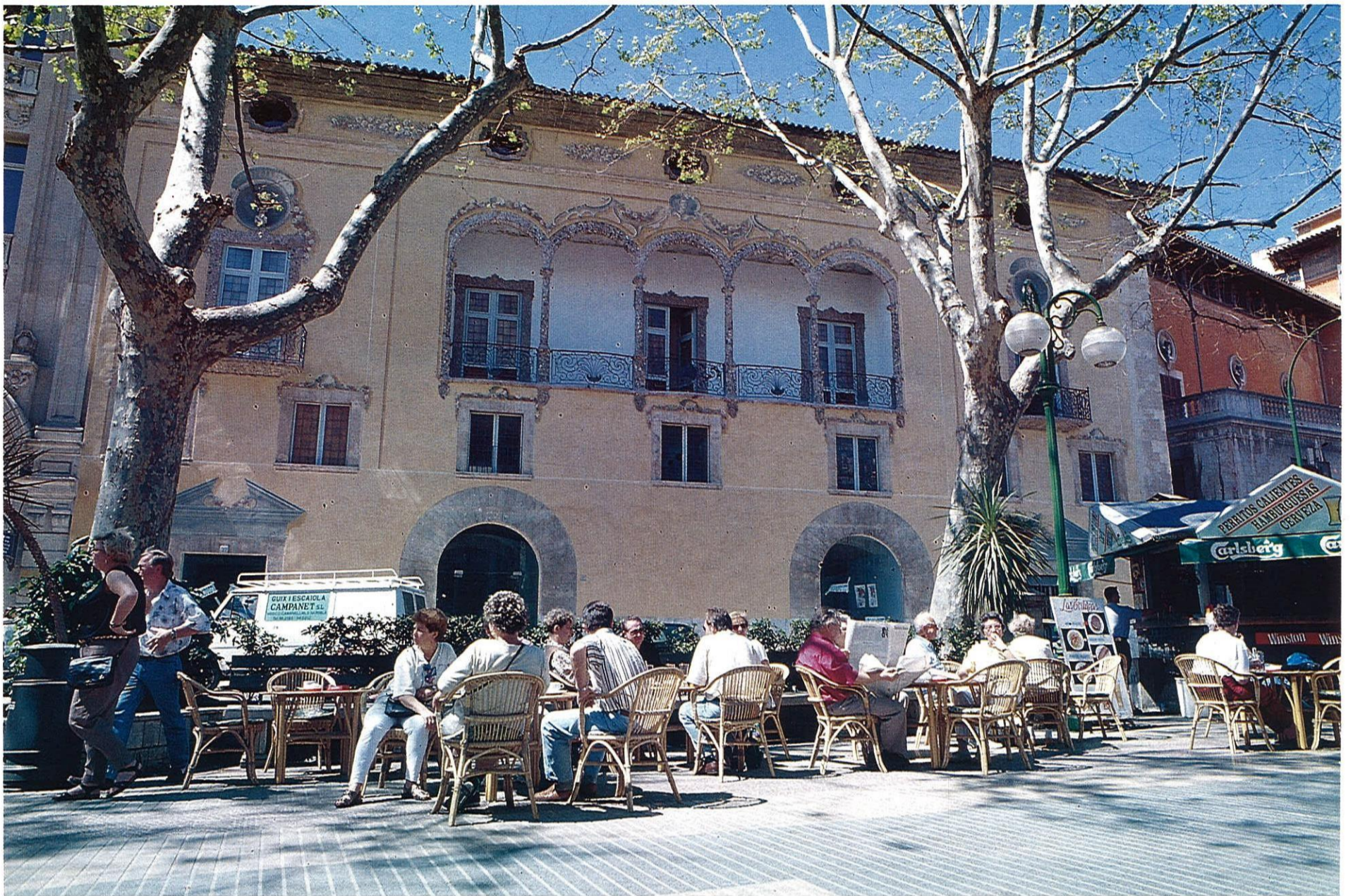
Con la restauración se ha reabierto la entrada en la fachada que da al Paseo del Born. Imagen tomada desde el Passeig, con el chiringuito en primer plano. FOTO: BARTOMEU AMENGUAL
